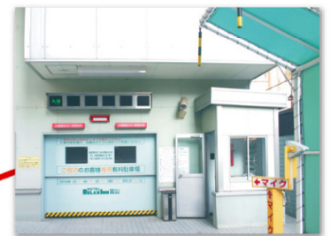
立体駐車場正面
